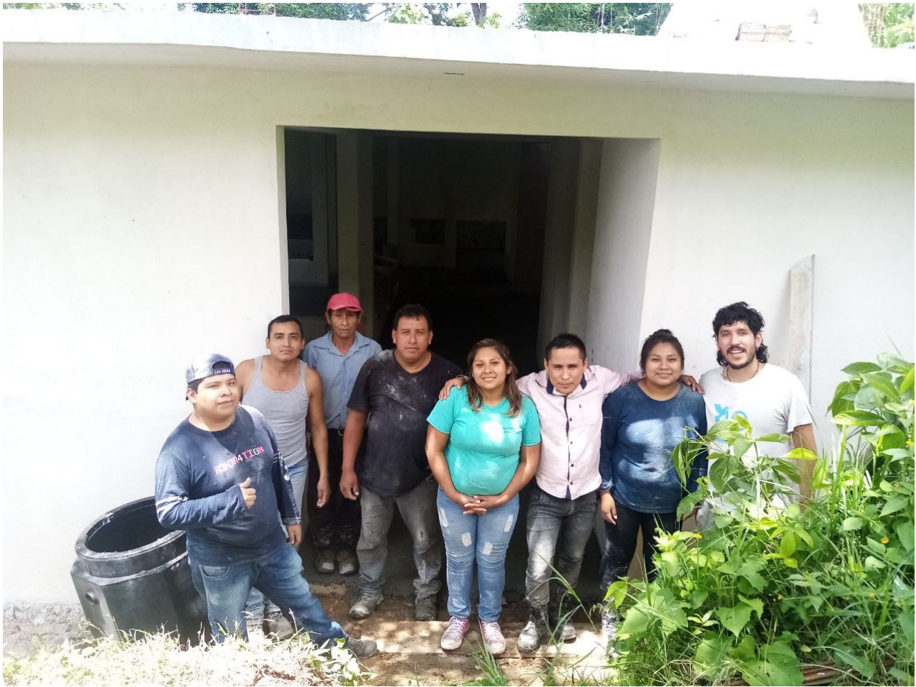
Imagen 14: Término de la Casa de Comunicaciones
